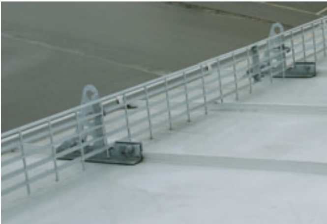
Snörasskydd i gallerdurk med israstapp monterat med falsfäste på plåttak.
