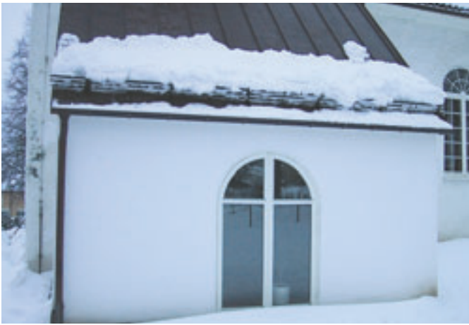
Snörasskydd med tre rör, monterat med falsfäste på plåttak.
