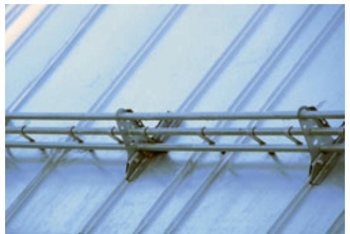
Snörasskydd med tre rör och israstappar.
