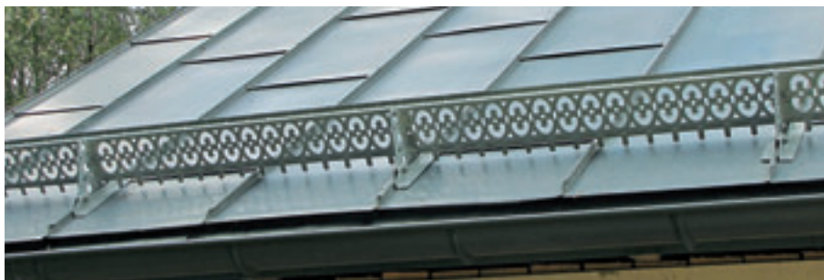
Snörasskydd i profildurk med specialmönster och israstappar.
