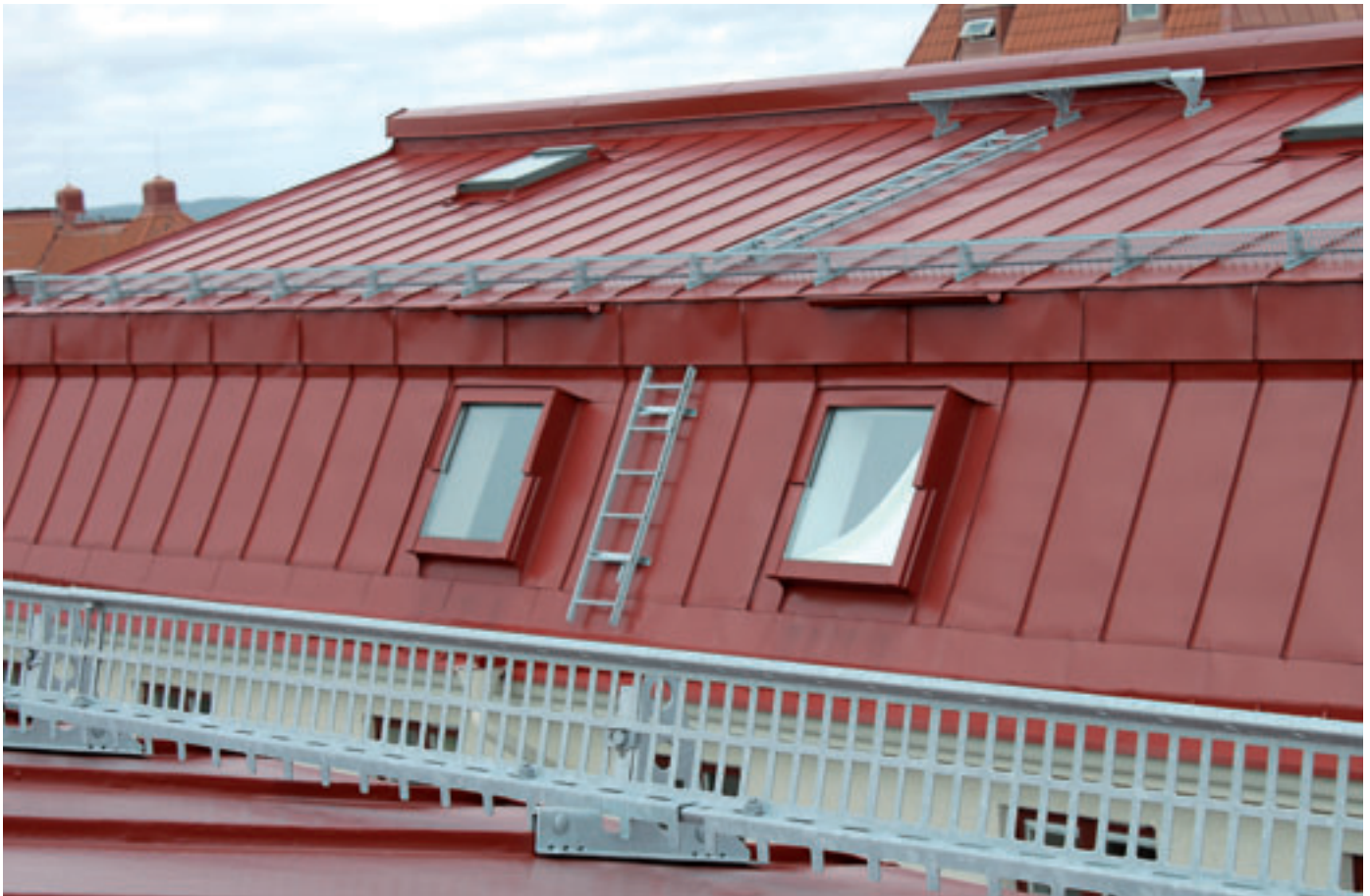
Snörasskydd i profildurk som kompletterats med israstappar.
