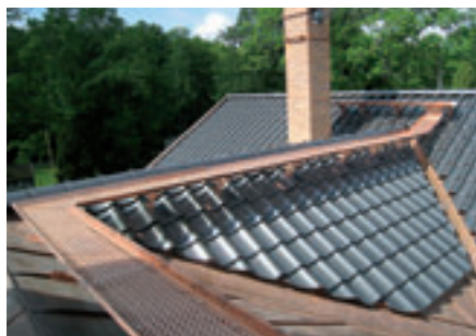
Takbrygga i koppar.
