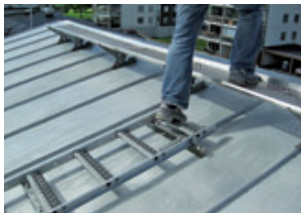
Takstege och takbrygga i rostfritt.
