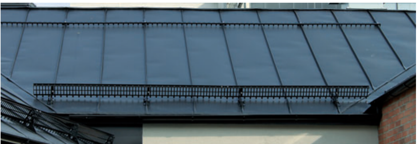
Snökratta monterad ovanför snörasskydd i profildurk med israstappar. Absolut bästa skydd mot isras.
