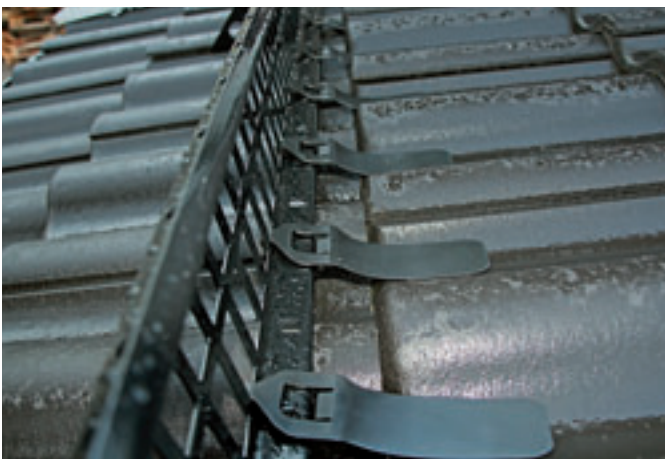
Israstapp monterat på snörasskydd i profildurk.
