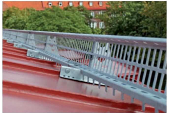
Snörasskydd i profildurk med påmonterad snökratta.
