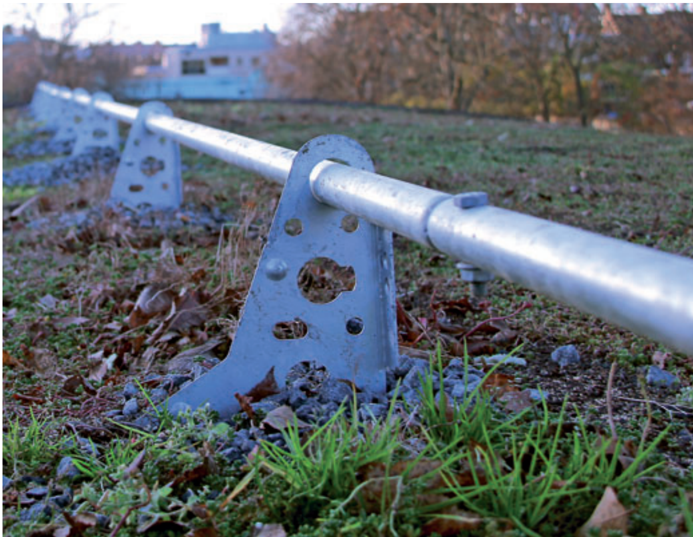
Varmförzinkat nochräcke på sedumtak.
