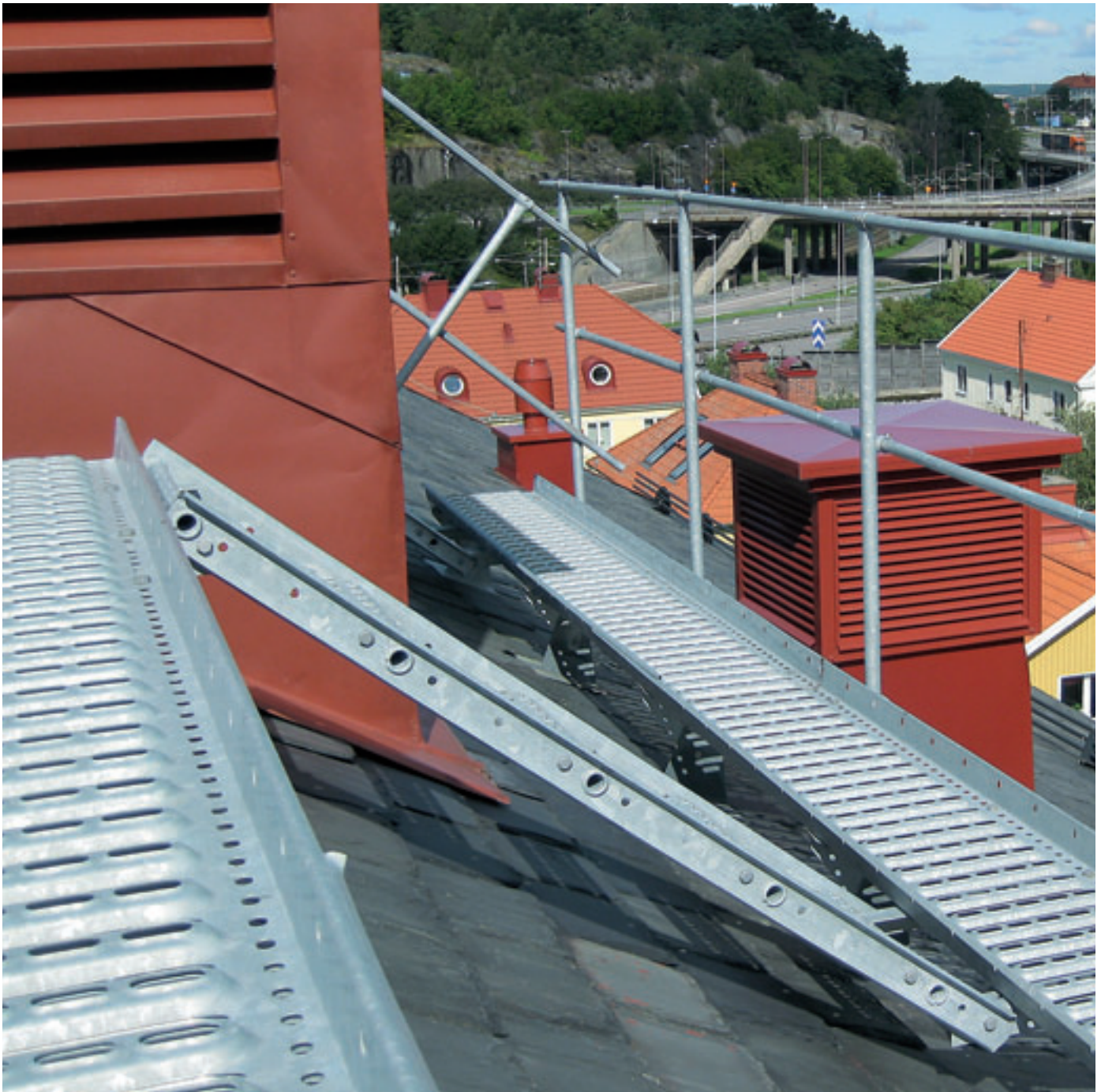
Takbryggor och takstege på skiffertak. Takbryggan har räcke för ökad säkerhet vid takarbete.
