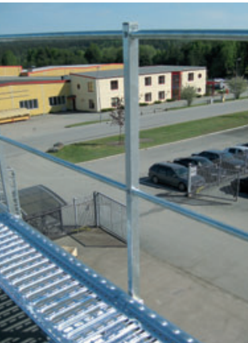
Räcke på takbrygga.
