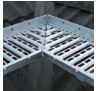
Hörnskarv på gångbrygga.
