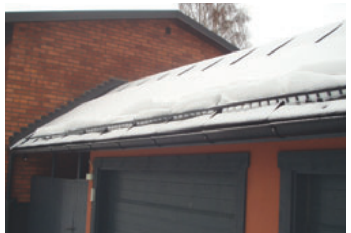
Snökratta monterad på plåttak.
