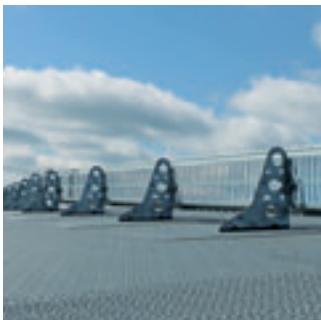
Montage på takduk.
