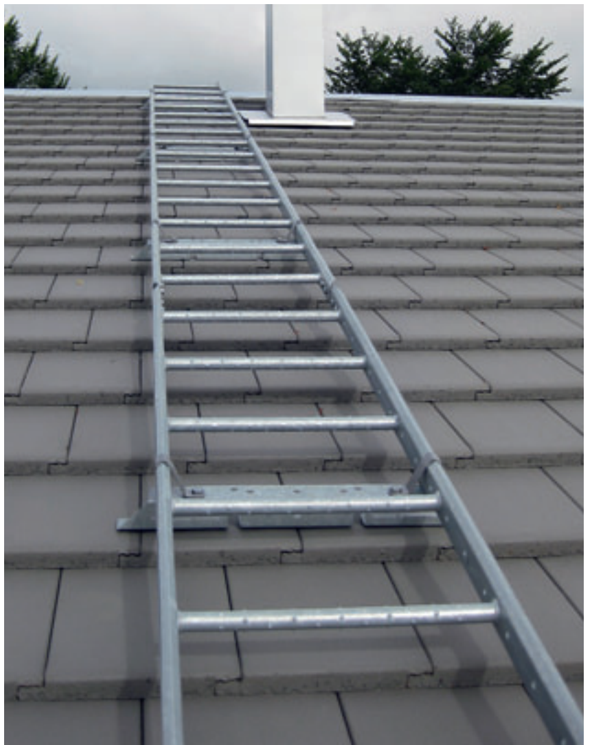
Takstege på tak med platta takpannor.
