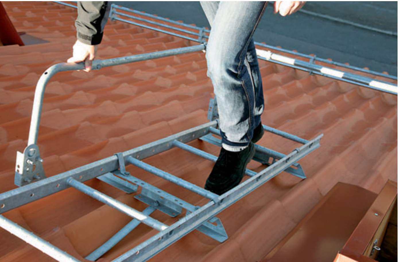
Takstege och skyddsräcke i anslutning till taklucka.
