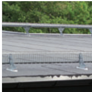
Montage med förhöjd tät-plåt på papptak.
