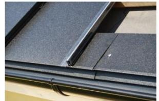
Anschlüsse zum Windbrett werden der Dachbreite angepasst, damit beide Giebelseiten symmetrisch aussehen.
