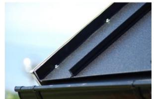
Die Windbretter werden an der Dachtraufe mit einer Umfalzung abgeschlossen.
