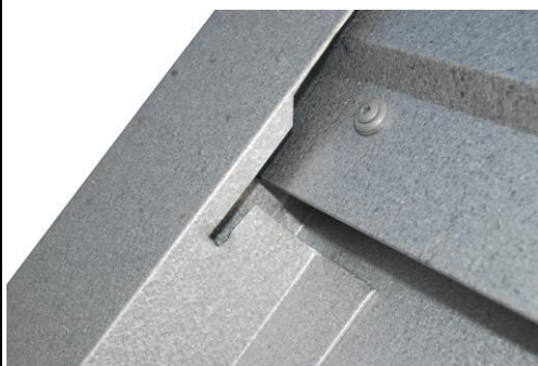
Das Ortgangprofil wird über den First geschoben.
