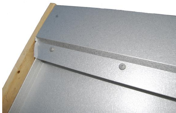
Biegen Sie die Ableitkante über den Falz
