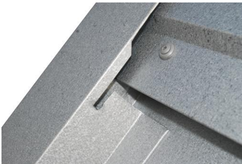
Das Ortgangprofil wird über den First geschoben.
