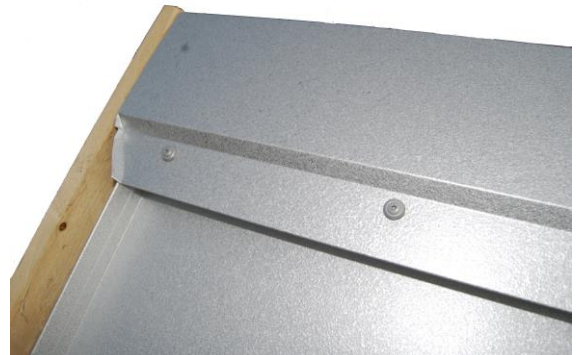
Biegen Sie die Ableitkante über den Falz
