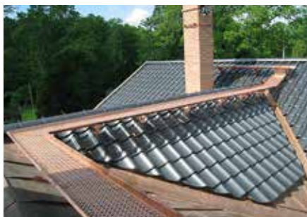
Takbrygga i koppar.
