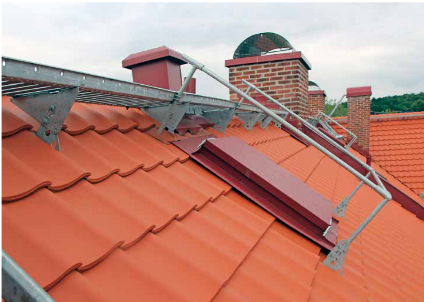
Takbryggor och skyddsräcke på panntak.
