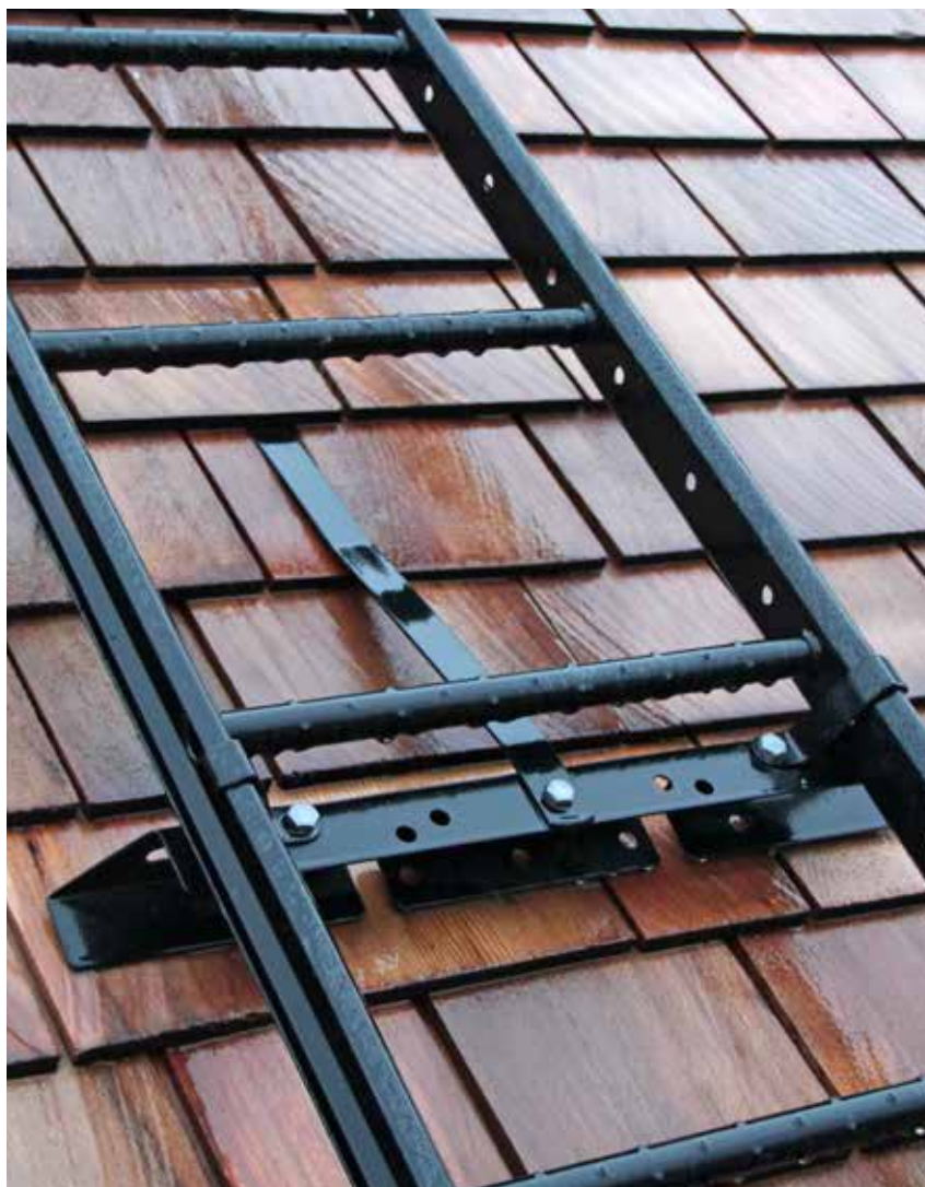
Takstege på tak med takpannor av cederträ.
