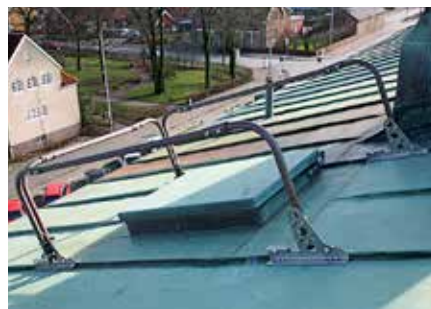
Skyddsräcke med rör av koppar och fästen i rostfritt.
