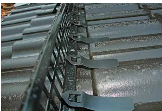
Israsskydd monterat på snörasskydd i profildurk.
