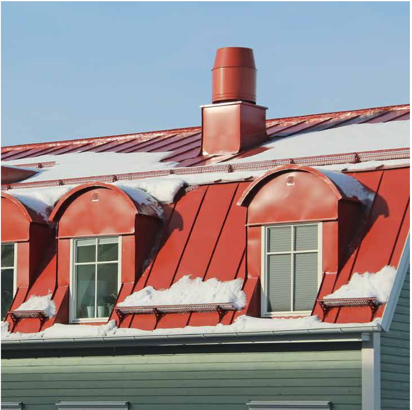
Snörasskydd på falsat plåttak.
