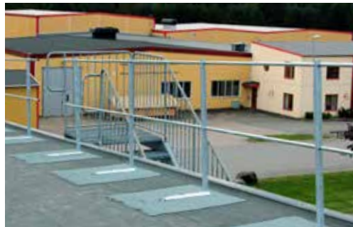
Skyddsräcke monterat med tätplåt.
