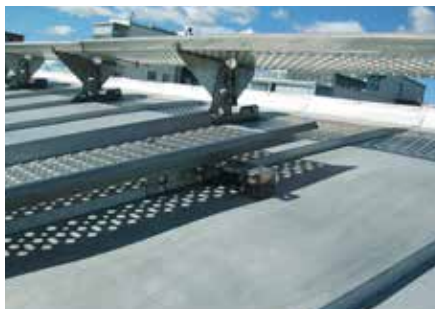
Takstege och takbrygga i rostfritt.
