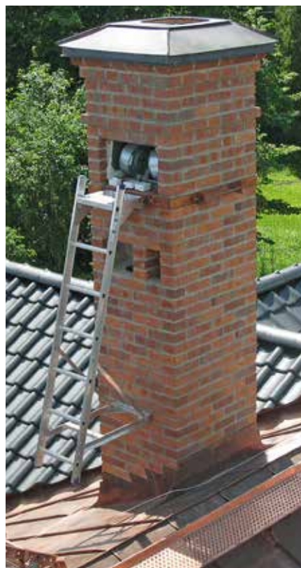
Skorstensband i koppar och lösstege i aluminium.
