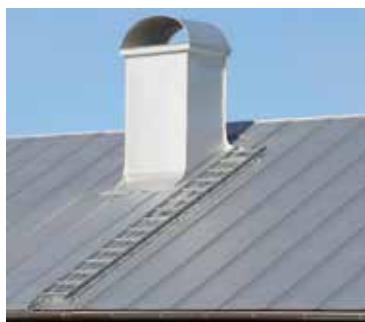
Takstege på falsat plåttak
