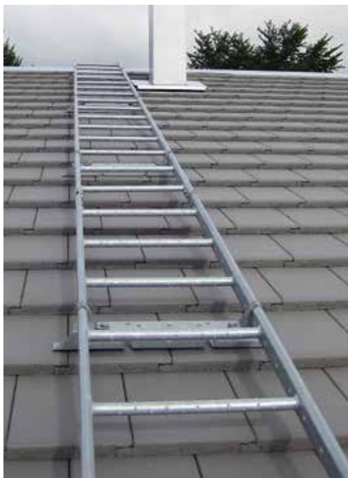
Takstege på tak med platta takpannor.
