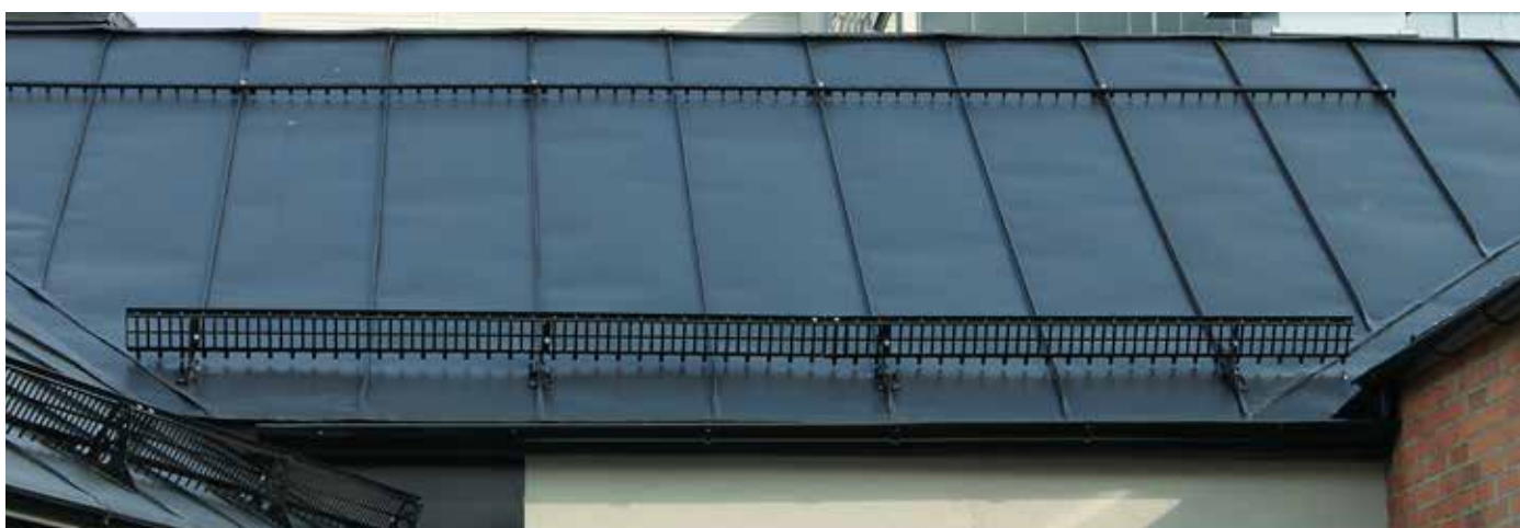
Snökkratta monterad ovanför snörasskydd i profildurk med israstappar. Absolut bästa skydd mot isras.
