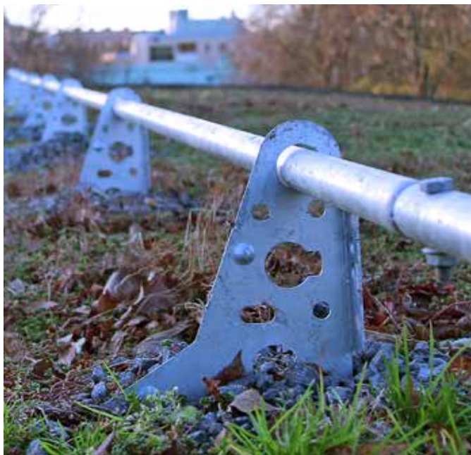
Varmförzinkat nockrärke på sedumtak.
