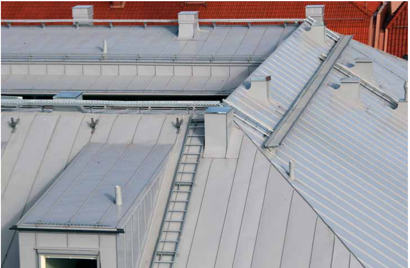
Takbryggor och takstegar på falsat plåttak.
