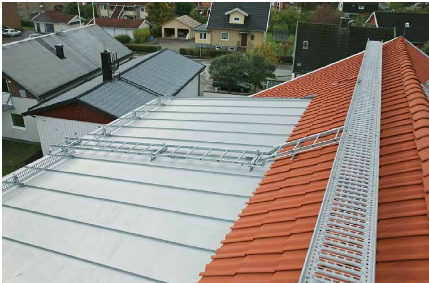
Takbrygga, takstege och snörasskydd.
