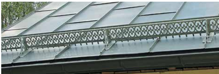
Snörasskydd i profildurk med specialmönster och israstappar.
