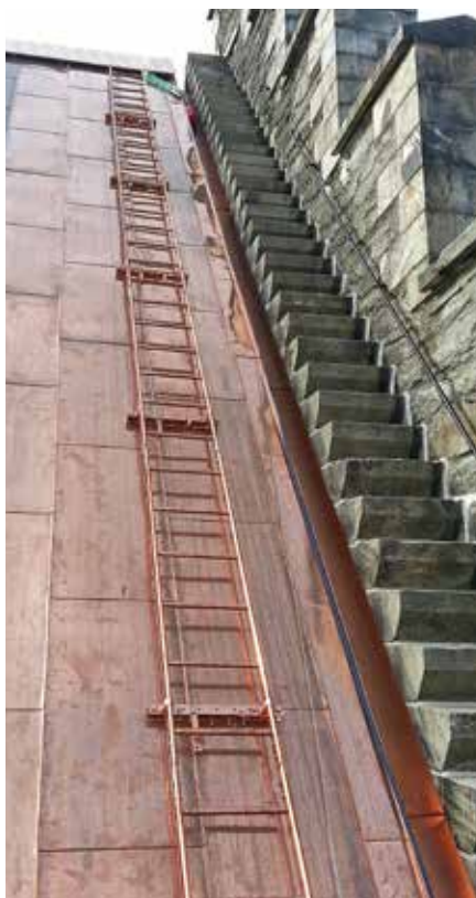
Takstege i koppar.
